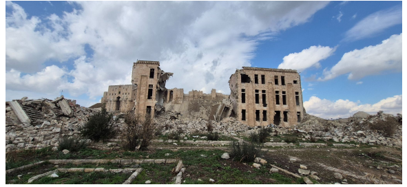
صورة ٣ - دمار التراث الثقافي في مدينة حلب القديمة - الجهة الجنوبي من مبنى السرايا وقلعة حلب. المصدر: يوسف كنجو شباط ٢٠٢٥
